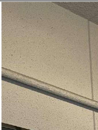
Photo n° PhA002 Localisation : 6ème étage - Salle radar Ouvrage : 3 - Parois verticales intérieures - Murs et cloisons maçonnés Partie d'ouvrage : Enduit à base de plâtre projeté Description : Enduit à base de plâtre projeté
